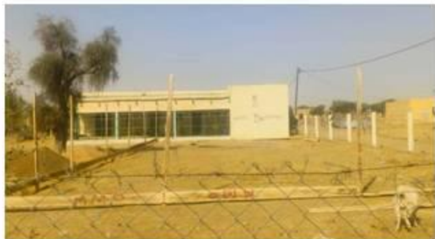
Chantier le 11 Novembre 2023
