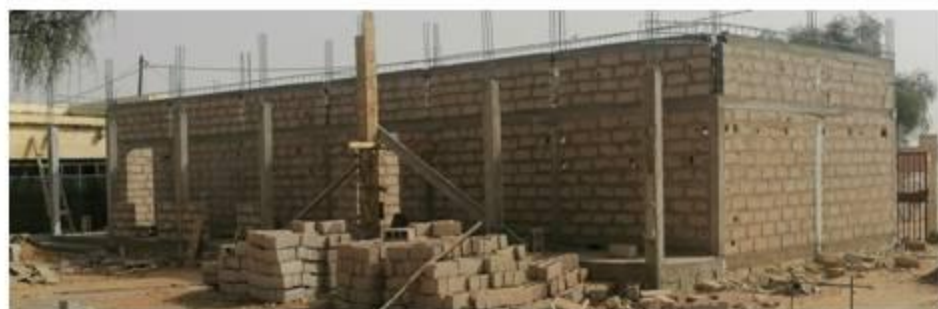
Chantier le 17 décembre 2023
