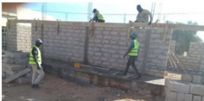
Chantier le 07 décembre 2023
