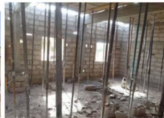
Chantier le 06 février 2024 : Dalle du toit en terrasse prête à être coulée
