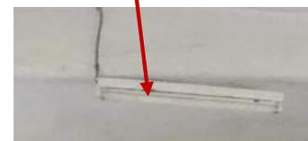
Dans ces 2 salles de classes, le support du tube fluo est à remettre en place pour l'un et la fixation de l'autre est à consolider.
