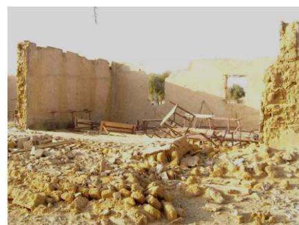
Ruines des bâtiments, construits avec de mauvais matériaux, détruits par le temps et les intempéries
