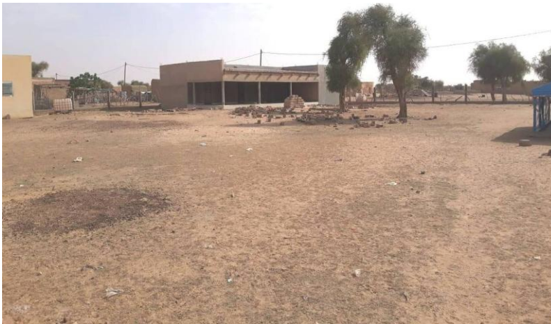
Situation actuelle de la cour sécurisée par une clôture de 40 m x 30 m
